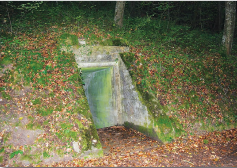
Abri pour dépôt de munitions.
